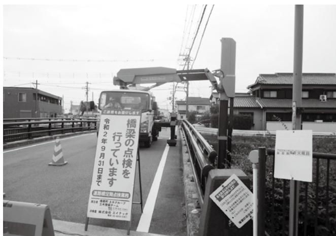
橋の安全確認
