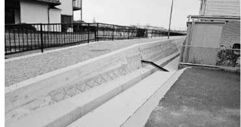
大池堤体改修工事中
